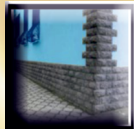
Наружные работы: фасад/цоколь
