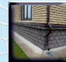
Наружные работы: фасад/цоколь
