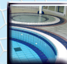
Небольшие крытые резервуары и бассейны
